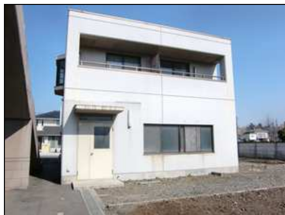
南側からみた事務所（2階の左）
