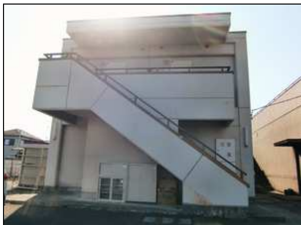
北側からみた事務所（2階の右）
